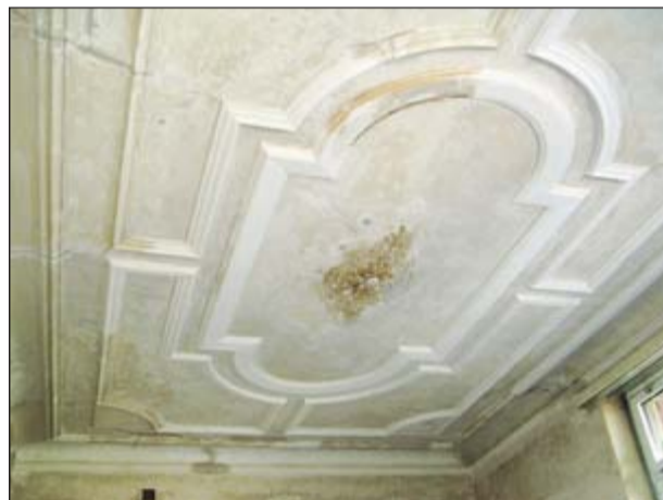
Wo zuvor ein gewaltiges Loch in der Decke klawte, ist nach den Sanierungsmaßnahmen des Stuckateurbetriebes Stüttler wieder der ursprüngliche Zustand hergestellt. Fotos: Privat
