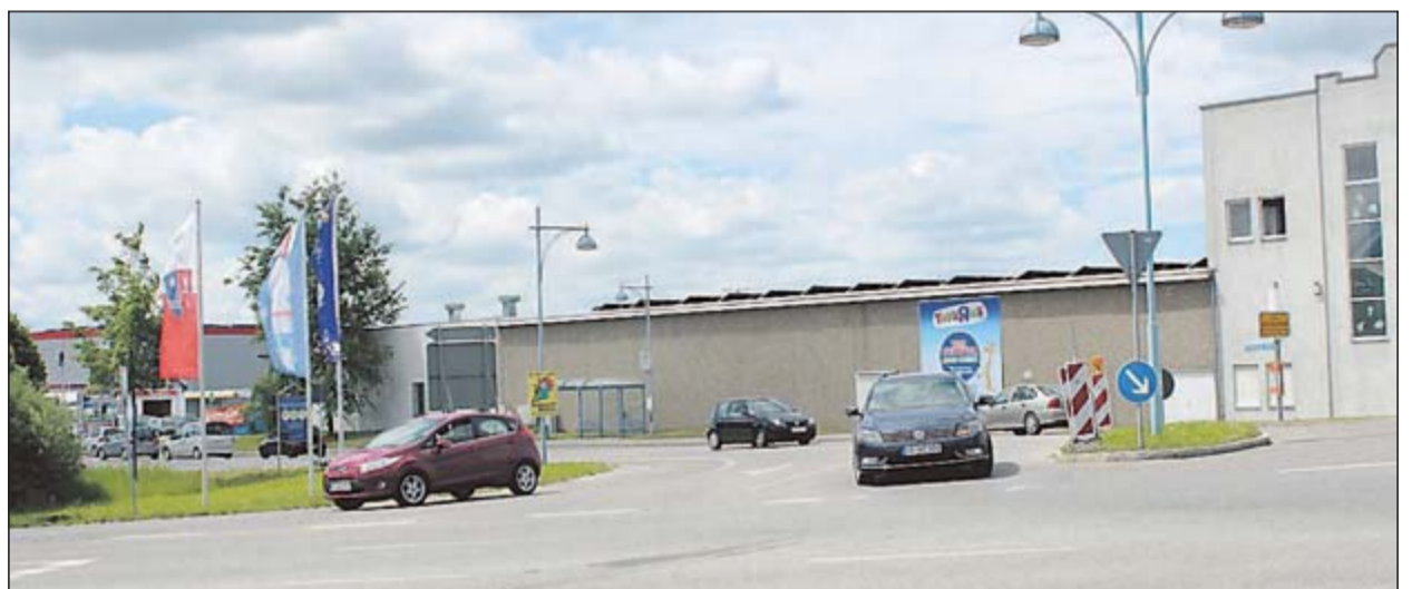
Die Kreuzung am E-Center in Richtung Schwenningen ist ein Unfallschwerpunkt, ein Kreisverkehr soll sie entschärfen, die Bauarbeiten und die Straßensanierung beginnen am Montag. Foto: Hans-Jürgen Eisenmann
