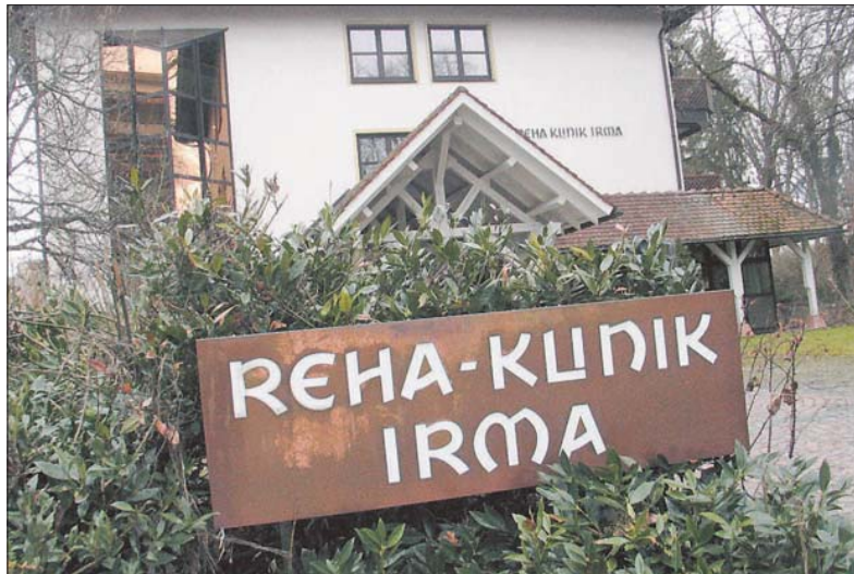
Die ehemalige Reha-Klinik Irma soll abgerissen werden.
